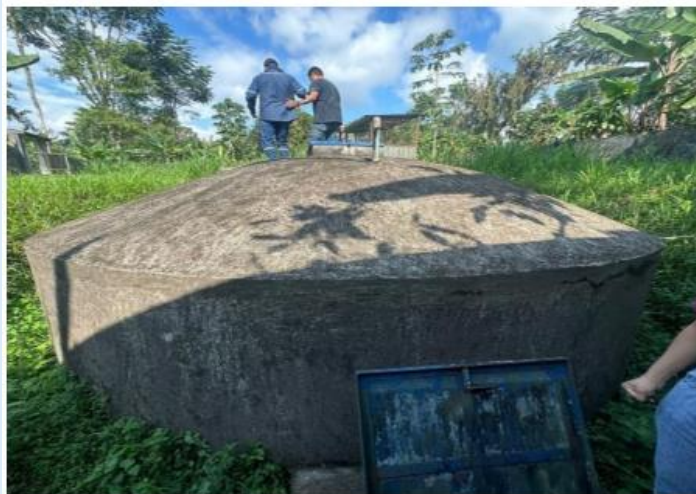
Tanque de Reserva
